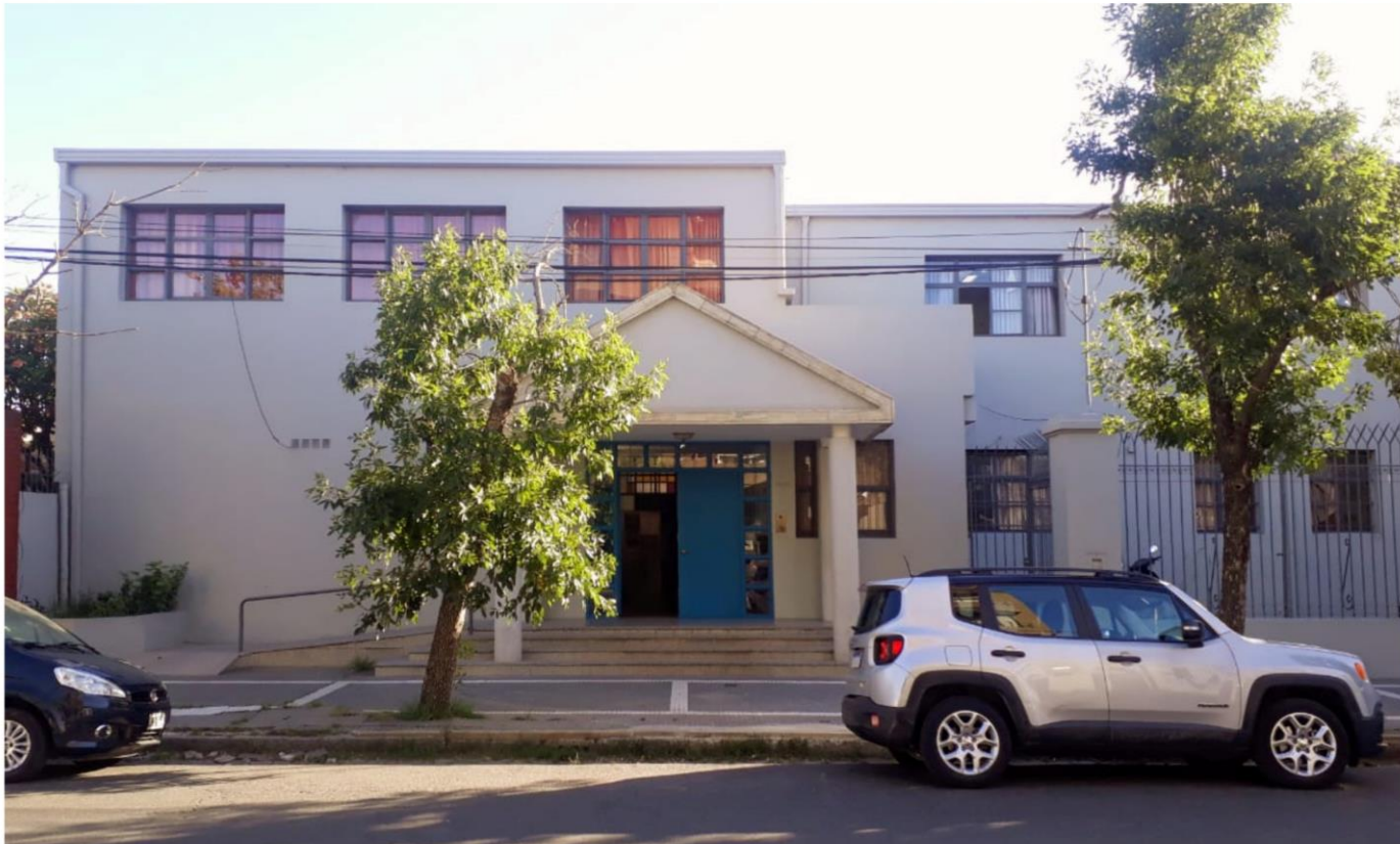
RENOVACIÓN I: Mejoras edilicias
